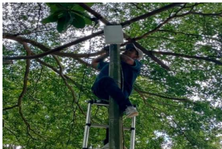
Gb 3.54 Pemasangan Access point untuk wifi publik di area Taman Pengayoman
