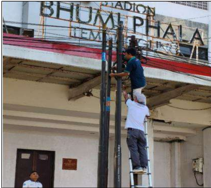
Gb 3.55 Perbaikan jaringan fiber optik
