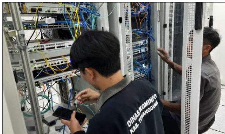
Gb 3.53 Maintenance perangkat jaringan di Data Center Pemkab
