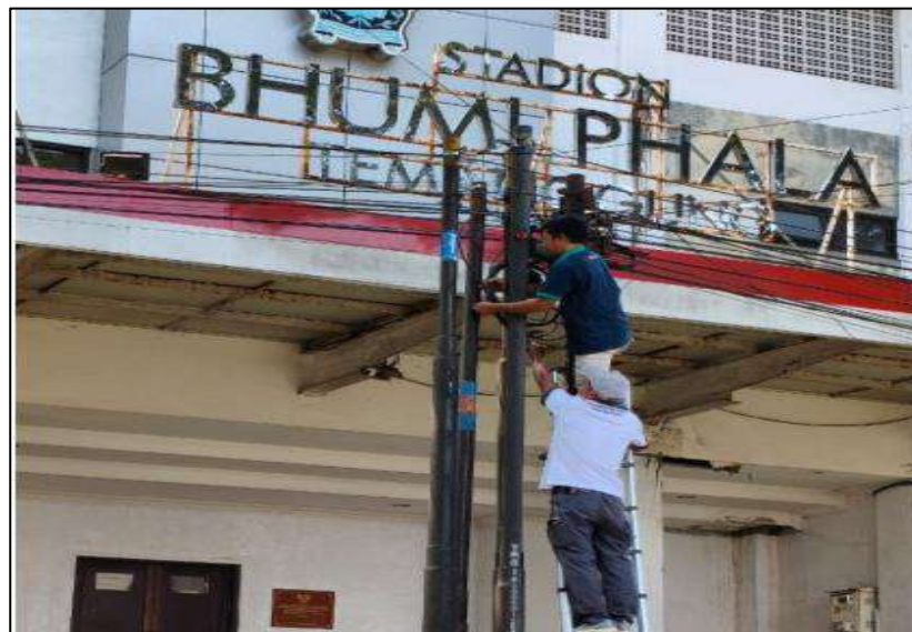
Gb 3.4 Pemasangan Jaringan Fiber Optic (FO)
